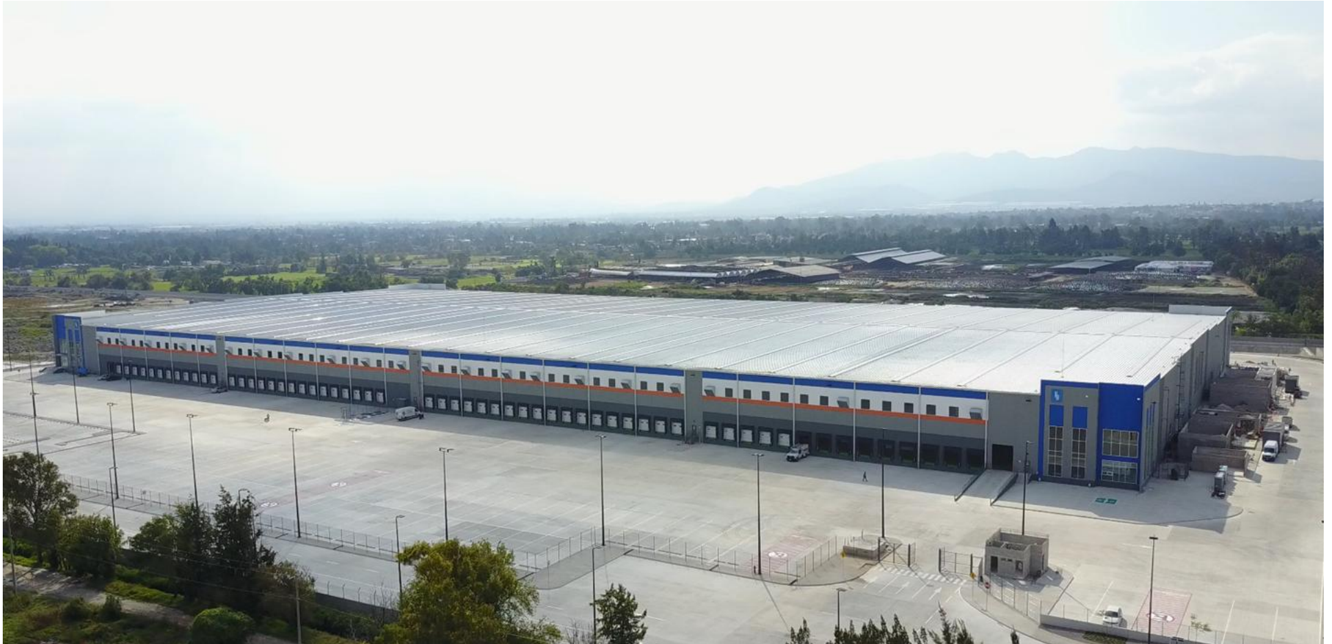
Danhos Industrial Palomas Nave I
